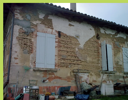
Presbytère de La Salvetat Belmontet avant travaux
