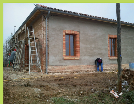
Presbytère de La Salvetat Belmontet en cours de rénovation
