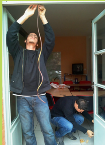
Pose de petits matériels d'économies d'énergie et d'eau
