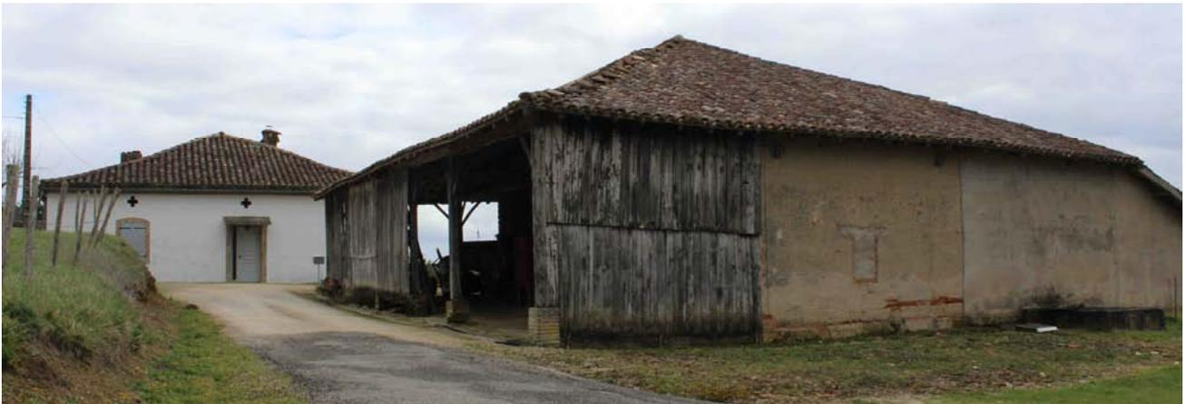
Binôme logis et grange-étable à La Revelle. L'auvent sur poteaux a été fermé par un bardage de bois.
