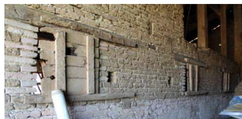
Grange-étable à Cavaillé. Vue des ais à glissière percées dans le mur séparant l'étable de la grange.
