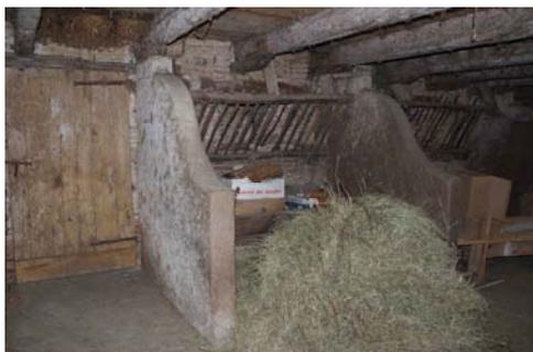
Grange-étable à la Serre. Détail d'une stalle pour vaches et des abats-flancs monolithes en calcaire.
