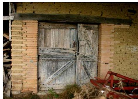
Grange-étable à Clapas, élévation antérieure. Les piédroits de la porte de l'étable sont réalisés en terre cuite. Le format identique de la brique cuite et de la brique crue permet leur combinaison (42x28x5cm) : la chaîne d'angle, pourtant sollicitée, comprend une alternance des deux matériaux et ce par souci d'économie.
