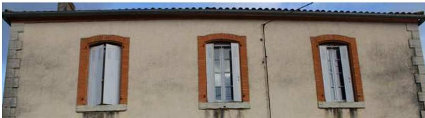
Détail des fenêtres de la mairie-école dont les travaux sont achevés en 1880. Les appuis de fenêtres et chaînes d'angles harpées sont en calcaire de Septfonds.
