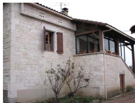
Logis à porche surélevé à Pontié-Haut. Dans l'angle de la façade, une aire d'envol signale la présence d'un pigeonnier dans le comble. Cet aménagement est courant dans les fermes de Lapenche quelle que soit la typologie du logis.
