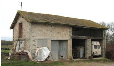
Dépendance de la ferme de Bargal construite en 1949 (porte la date). Elle montre l'engouement pour les matériaux « nouveaux » diffusés durant la 1<sup>ère</sup> moitié du XX<sup>e</sup> siècle : pilier en parpaings de béton, ciment, briques creuses, tuiles plates mécaniques.
