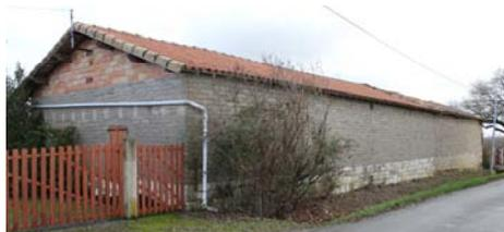
Dépendance agricole à Naudou. Murs en parpaings de béton et briques creuses sur un solin de calcaire.
