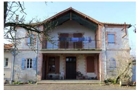
Logis aux Gabachs construit en 1922. Le porche dans-œuvre est ici surmonté d'une galerie. Un couloir traversant dessert une cuisine située dans l'avant-corps gauche. L'avant-corps droit reçoit l'escalier qui mène à l'étage. Les élévations en moellons de calcaire et l'utilisation de la brique pour les piédroits harpés, les chaînages et la corniche à modillons apportent un jeu de bichromie aux élévations.
