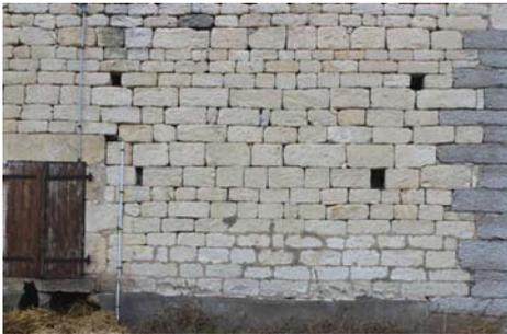
Maçonnerie d'un pigeonnier à Faugère. Il s'agit de l'un des rares exemples de mur en calcaire blanc où la chaîne d'angle est réalisée avec un calcaire d'une autre provenance. Pigeonnier postérieur à 1834 puisqu'il ne figure pas sur le plan cadastral.
