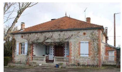
Logis à Gabach construit en 1934. Un soin particulier est accordé à la façade qui grâce à de nouveaux matériaux (linteau en béton, tuiles plates mécaniques, éléments en terre cuite moulés) réinterprète un modèle plus ancien : le logis à porche dans œuvre.
