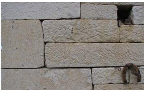
Vue de détail du mur de la grange-étable à Bargal. La qualité de la taille des blocs à arêtes vives a permis de réaliser des joints très minces, non perceptibles. Les élévations sont en pierre de taille régulièrement assisée tandis que le mur-pignon sous l'auvent est en moellon.
