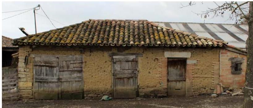
Castanet, petite dépendance polyvalente avec logement, 2ème moitié du XIXe siècle. La façade (sud-est) en adobe repose sur un solin en calcaire, les autres élévations sont en briques (cuites) et moellons de calcaire.
