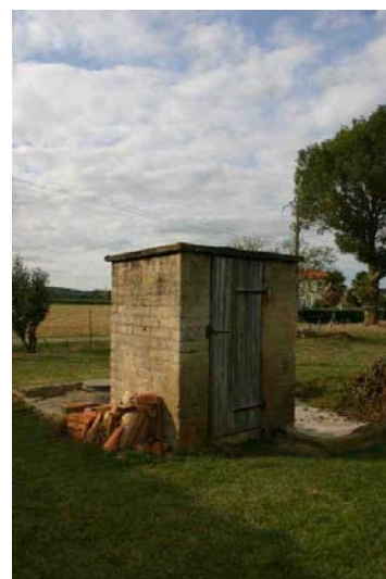
Ferme au Gravel, vue du cabinet de toilette construit dans les années 1930.
