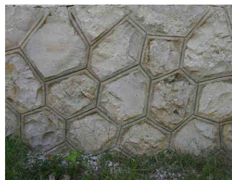
Soubassement en moellons de calcaire jointoyés au ciment, années 1930, Hauterive.
