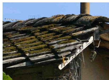
Détail de la couverture en tuiles plates de ciment, aux Tessonniers.
