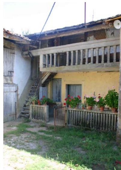
Logis des Tessonniers, vue de la façade sud-ouest.
