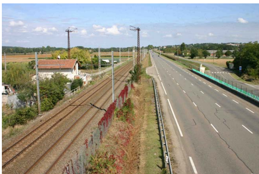
Vue sur la RD 820 et la voie ferrée avec la maison de garde-barrière au lieu-dit Tachères.
