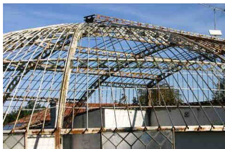
Serre construite dans les années 1980 à Fromant : elle rappelle des structures propres à la fin du XIXe ou au début du XXe siècle.
