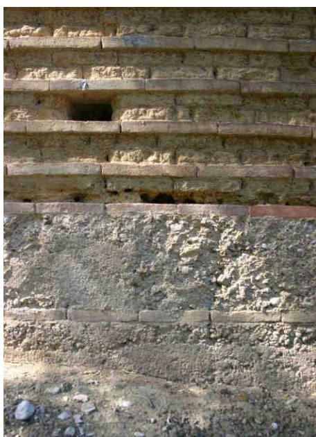
Maçonnerie de briques à assises alternées sur un soubassement en béton banché, à Martel.
