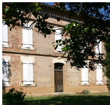
Logis à Pountet, vue de la façade sur route.
