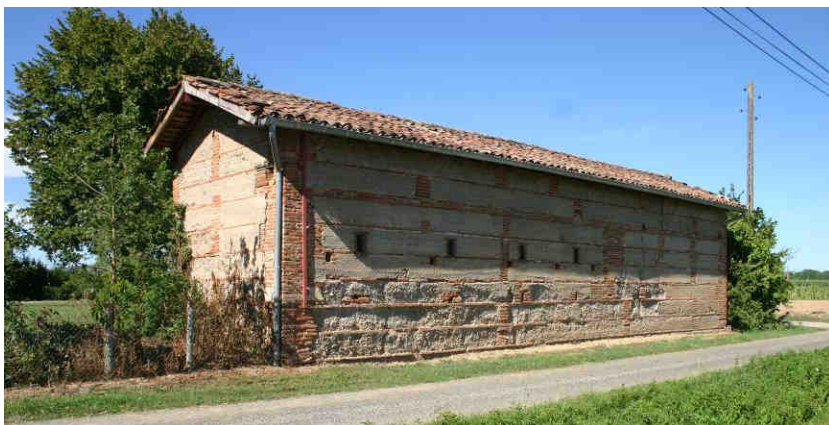
Dépendance en béton banché, Pountet.
