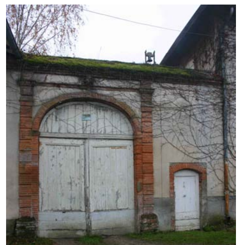
Maison de maître, ancien village de Cayrac, vue des portes cochère et piétonne.
