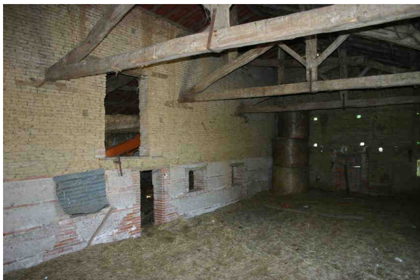
Ferme de Martel, vue intérieure de la grange.
