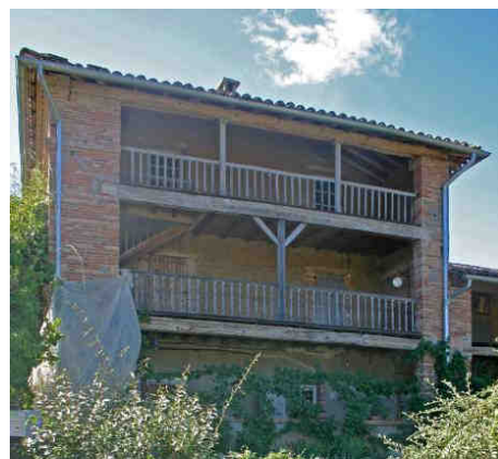
Logis à Pountet, vue de l'élevation sud-est.
