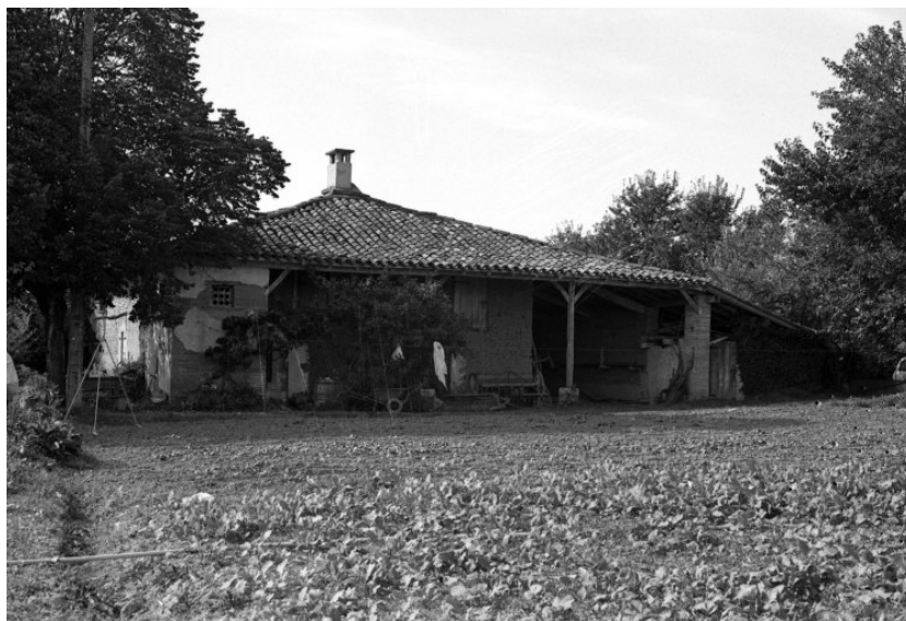
Ferme à Places Hautes, état dans les années 1980 (cliché SRI).
