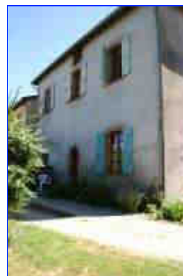
Ancienne mairie-école : vue de la façade postérieure.
