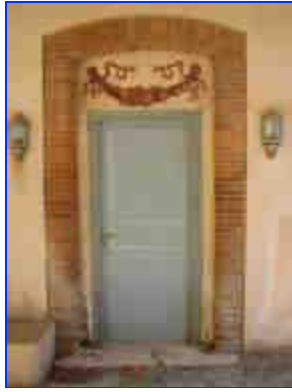
Dépendance : porche, porte d'entrée.
