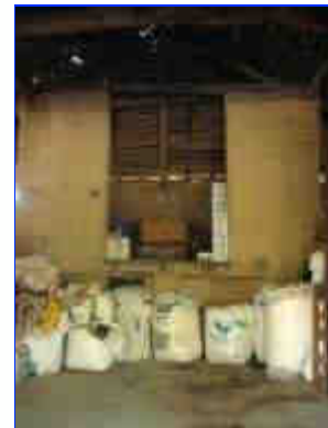
Vaisseau central servant de grange avec l'ouverture dans la partie supérieure pour accéder au fenil.
