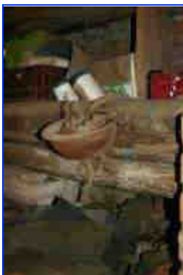
Grange-étable : détail d'un abreuvoir.
