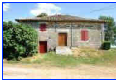
Logis : façade postérieure (nord-ouest).
