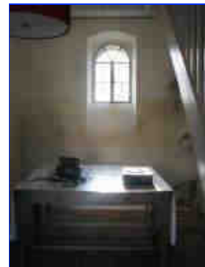
Dépendance : Détail d'une baie.
