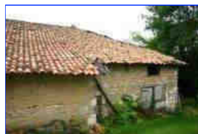
Grange-étable : vue de l'élévation nord.
