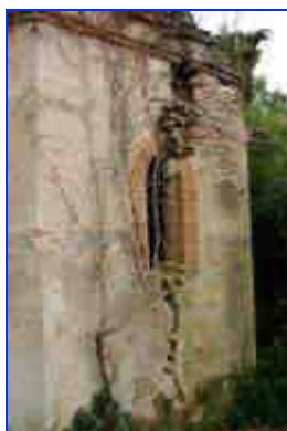
Détail de la travée ouest.
