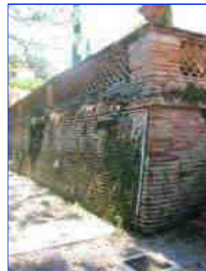
Vue du soubassement de la terrasse (nord-est).
