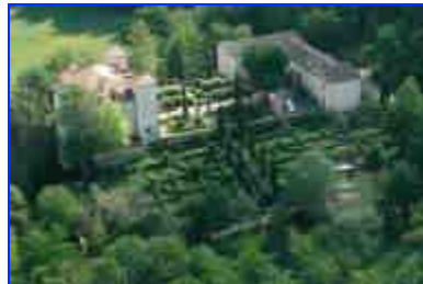
Vue aérienne du château.
