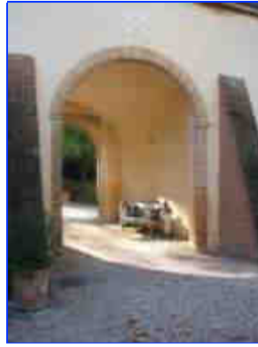
Dépendance : vue du porche depuis la cour intérieure.
