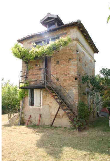
Figure 18 : Pigeonnier à Pech Del Py, élévation sud et est en brique cuite.
