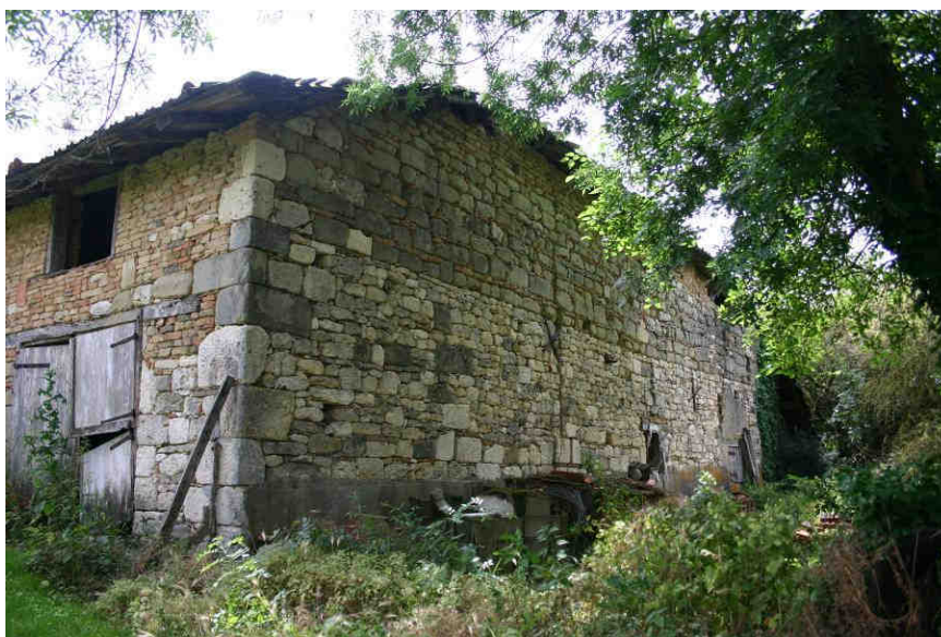
Figure 20 : Au Carla, grange-étable, vue de l'élévation ouest.
