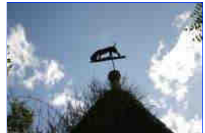
Détail de l'épi de faîtage et de la girouette.
