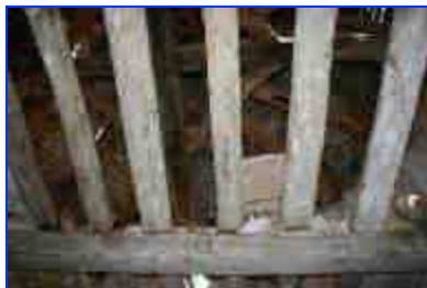
Intérieur, détail du plancher des combles.
