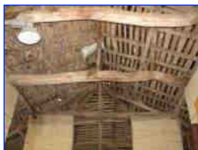
Détail de la charpente au centre de la grange.
