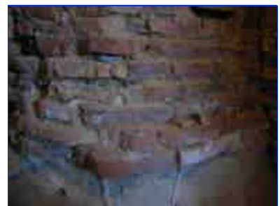
Soubassement du logis, salle voutée 1 : détail des maçonneries.
