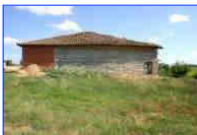
Grange-étable : élévation nord-ouest.
