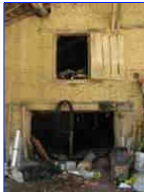
Grange-étable, vaisseau latéral sud abritant la bergerie et le fenil.
