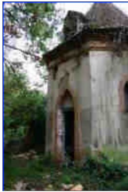
Vue d'ensemble de l'entrée est.
