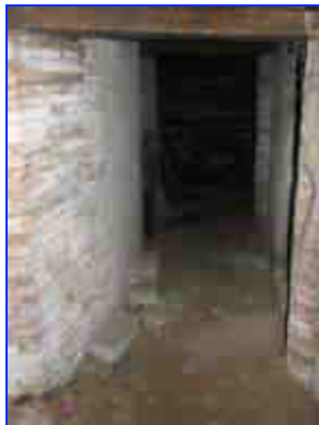
Logis, couloir de circulation dans la cave.
