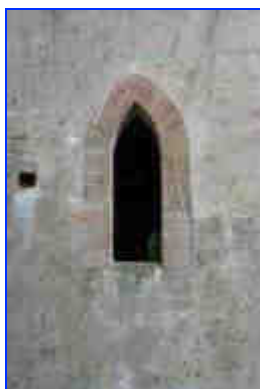
Détail d'une fenêtre.
