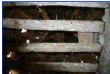
Intérieur, détail du plancher des combles et aperçu de la charpente.
