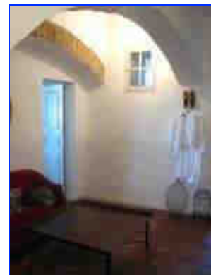
Logis, rez-de-chaussée : arcs de décharge sous l'escalier.
