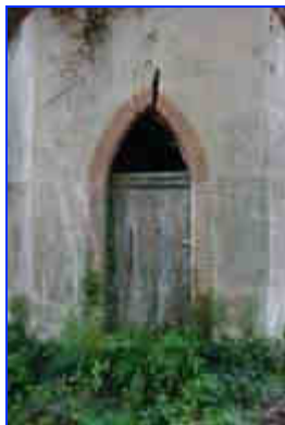
Détail de l'entrée nord.
