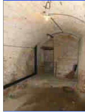
Logis, soubassement : vue de la salle 1 voûtée.
