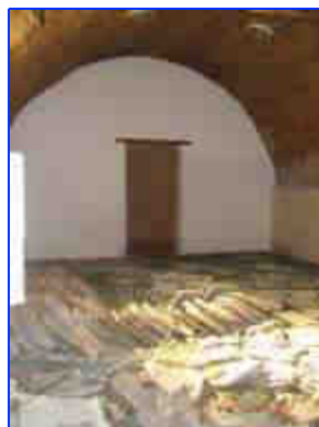
Dépendance : rez-de-chaussée, pièce voûtée.
