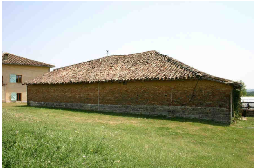
Figure 16 : Mur d'une grange-étable en moellons de calcaire, brique cuite et brique crue, à Pourramond.
