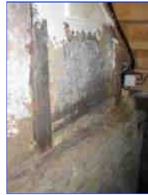
Logis, cloison intérieure en pan-de-bois.
