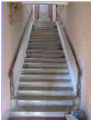
Logis, rez-de-chaussée : vue de l'escalier droit.
