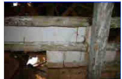
Intérieur, détail des carreaux de terre cuite du plancher des combles.
