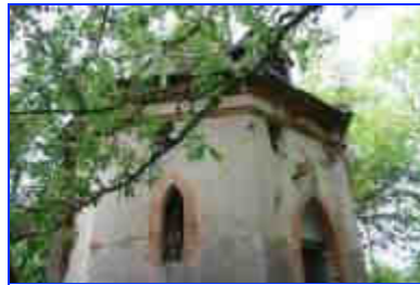
Détail des ouvertures depuis le sud-est.
