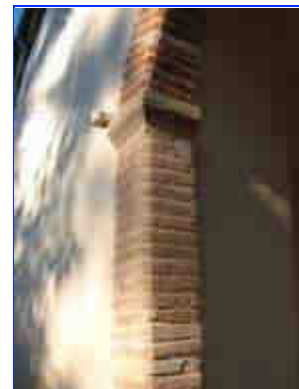
Dépendance : porche d'entrée, détail d'un piédroit.
