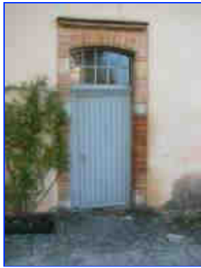
Dépendance : élévation nord-ouest, porte d'entrée.
