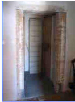
Logis, porte de distribution intérieure avec piédroits en briques chanfreinés et lineau en bois.
