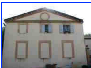
Dépendance : vue du pignon nord-ouest.
