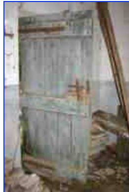
Intérieur, entrée est : détail de la porte.
