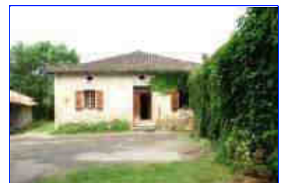
Logis, vue de l'élévation principale (est).
