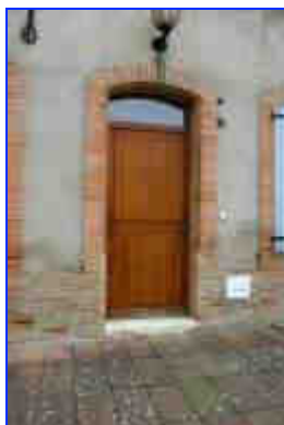
Façade principale : détail d'une ancienne fenêtre transformée en porte.
