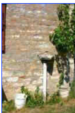
Logis : élévation sud-ouest, détail de la pierre d'évier.
