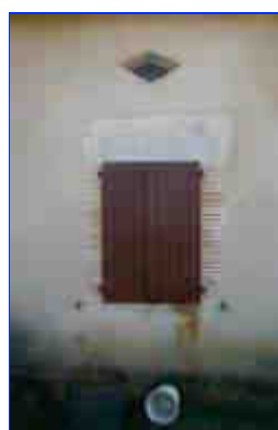
Logis : élévation nord-est, détail d'une baie.
