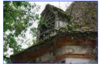
Détail de la lucarne est.
