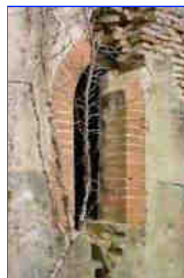
Détail de la fenêtre de la travée ouest.
