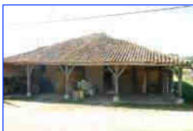
Grange-étable : élévation sud-est.
