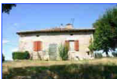
Logis : élévation sud-ouest.
