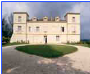
Vue de l'élévation antérieure.
