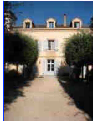
Logis : vue de la façade depuis l'allée centrale.
