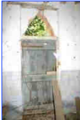
Intérieur, vue d'ensemble de l'entrée nord.
