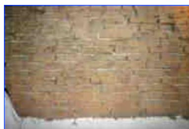
Logis : cave, détail d'un mur en brique crue.
