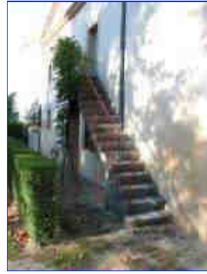
Dépendance : élévation principale, vue d'un escalier.
