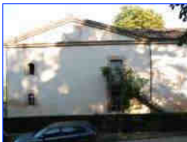
Dépendance : élévation principale, détail du pavillon sud.
