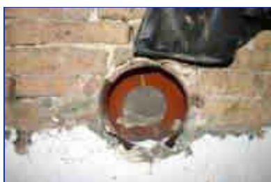
Logis : cave, détail d'un pot en terre cuite incrusté dans la maçonnerie.
