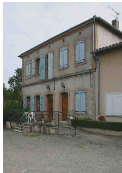
Figure 8 : Ancienne mairie-école, façade.
