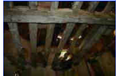
Intérieur, vue d'ensemble du plancher des combles.
