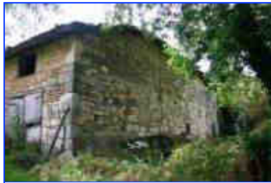
Grange-étable : vue de l'élévation ouest.
