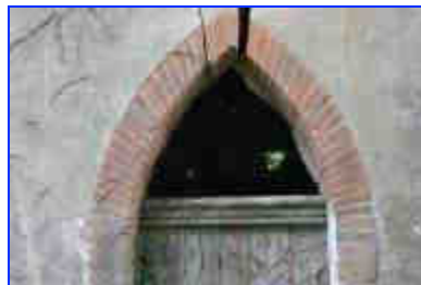
Entrée nord, détail de l'arc brisé.
