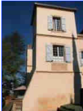
Logis : vue de la tourelle d'angle sud-ouest.
