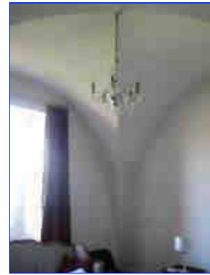
Vue de la voûte d'arêtes d'une chambre au rez-de-chaussée (vaulted sitting room).
