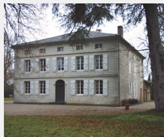
Logis de la ferme construit en 1866 en moellon de calcaire et en pierre de taille sur la façade principale (orientée au sud-est).
