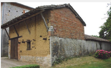
Vue d'ensemble des dalles à l'arrière du toit à porcs.
