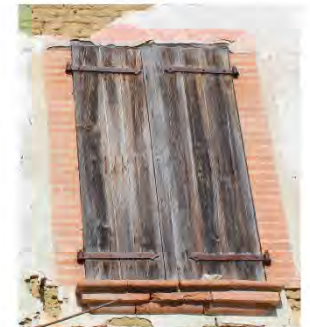
Logis à Paganou, dans un souci d'économie de moyens, l'enduit donne l'illusion d'un linteau en brique, alors qu'il est en bois.
