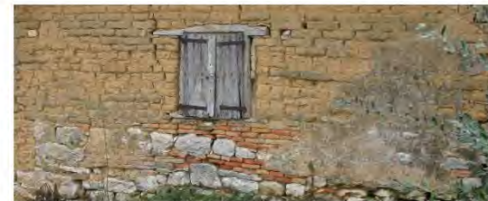
Emploi de matériaux différents à la Mouline Les briques, les moellons et probablement certaines briques crues sont des matériaux utilisés en remploi. Dans cette ferme modeste les encadrements des fenêtres sont de simples cadres de bois.
