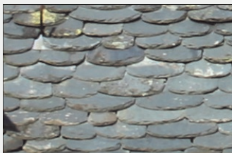
Ardoises taillées en écaille de poisson.
