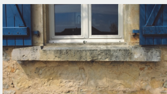
Appui d'une fenêtre du rez-de-chaussée.
