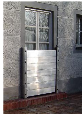
batardeau pour protéger l'habitation contre les inondations
