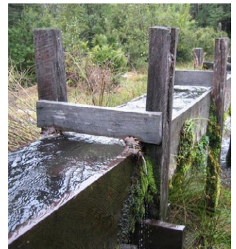
bief en aqueduc
