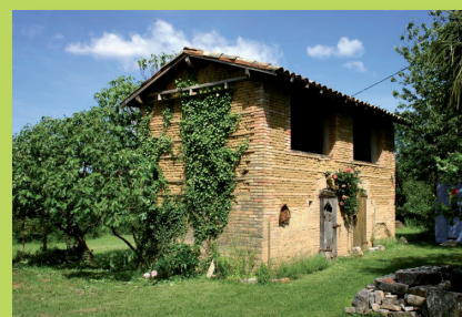
Remise étable - Génèbrières
