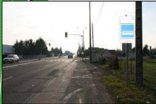
Des arrêts de bus avec des accès piétons protégés
