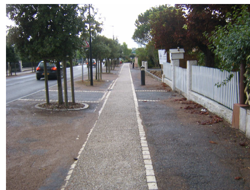
Bande cyclable à Caussade (Photo : F. Padié)
