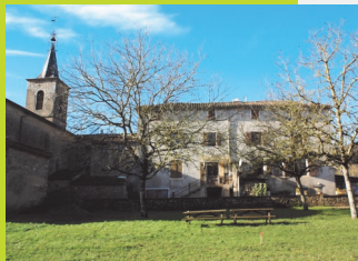
Vue du château et de l'église depuis l'est.
