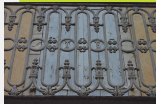
Détail d'un garde-corps en fonte de la 2 de moitié du XIX e siècle (10).
