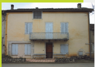
Maison face à la rue de l'église construite après 1850, qui a longtemps abrité un café au rez-de-chaussée (10).
