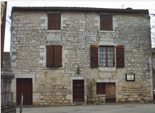
Maison, place du Perron (5).
