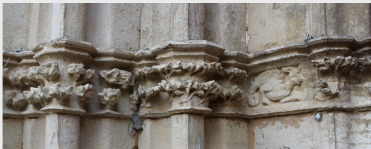
Portail nord, piédroit gauche.
