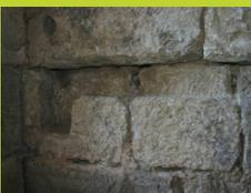
La porte Méjane est construite en pierre de taille calcaire. Sous la voûte en berceau brisé, les trous barrières pour fermer la porte sont encore en place. On peut aussi apercevoir sur certaines pierres, les marques lapidaires des maçons qui ont construit cette porte de ville. La pierre provient des carrières situées à proximité du bourg.
