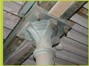
Chapiteau qui surmonte un pilier en fonte au premier étage (2007). Les étages du moulin désaffecté ont été vidés de tous leurs équipements.
