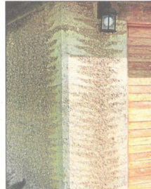
Détail d'un angle en pisé
