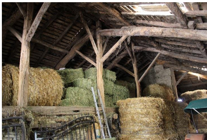
Grange-étable à deux travées à Piboul. Le mur-bahut qui sépare la grange de l'étable reçoit les poteaux de la charpente. Les essences de bois communément employées pour les charpentes sont le peuplier et le chêne.
