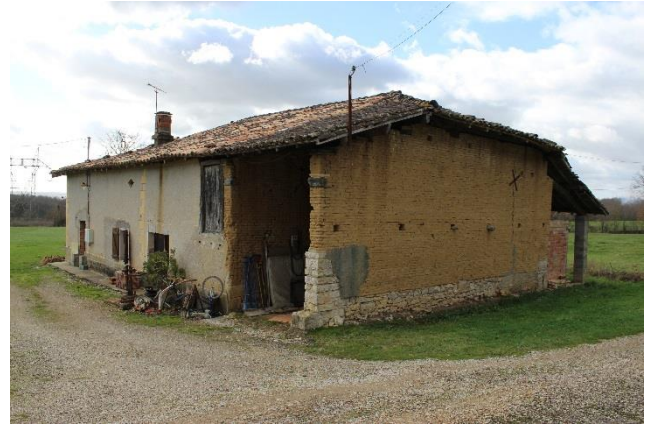
Ferme de Pech-del-Barry, rare « maison-ferme » de plan massé en adobe abritant un logement avec une façade ordonnancée, une grange, une étable et une remise sous un même toit. Le volume de cette ferme se confond avec celui des granges-étables des coteaux du bas-Quercy.
