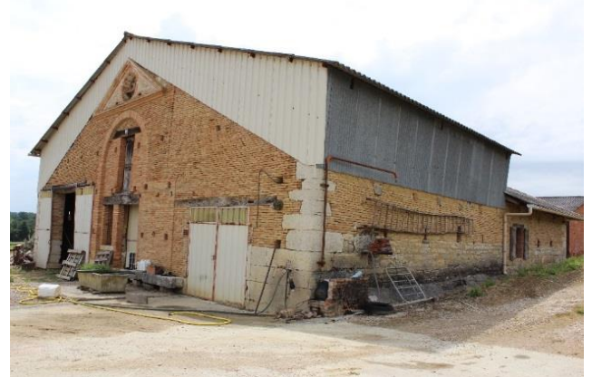
Grange-étable au Soulié. La façade sur le mur-pignon, d'inspiration néoclassique est soignée. Elle se distingue de l'architecture rurale vernaculaire. (Au cours du XXe siècle, la couverture a été déposée et remplacée par une toiture métallique).
