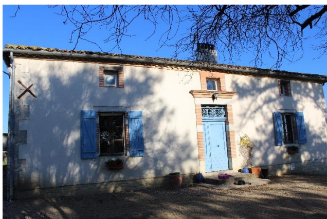
Logis aux Coudercs (voir plan p.36) à trois travées d'ouvertures. La travée centrale, axe de symétrie de la façade, reçoit un soin particulier. La porte est en effet pourvue d'une grille d'imposte en fer forgé, d'un linteau portant la date 1869 couronné d'un entablement sculpté.
