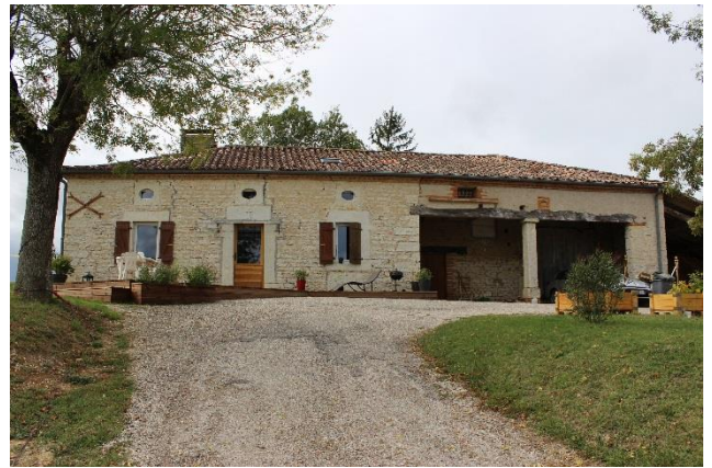
Ferme de Rimepoul. Il s'agit ici également d'une « maison-ferme » organisée de façon longitudinale. Ici le matériau du logis (calcaire) se distingue de celui utilisé pour l'étable (adobe).
