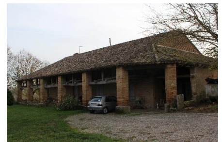
Castel-bas, logis, vue depuis le nord-ouest.
