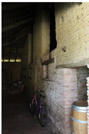
Grange-étable à Marnhiou. Vue des grandes ouvertures qui permettent de déverser le foin dans le fenil depuis la grange.
