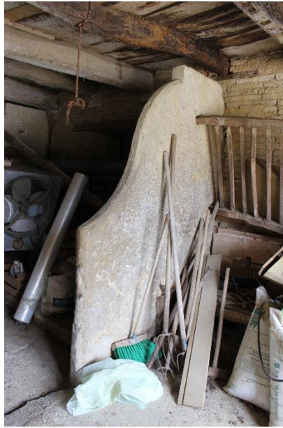
Bat-flancs monolithes dans la grange-étable au Soulié.
