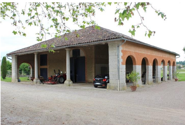
Grange-étable à Roucou. Elle est révélatrice de la parfaite maîtrise du système constructif alliant la brique crue à la brique cuite avec l'introduction d'éléments exceptionnels en pierre de taille calcaire.
