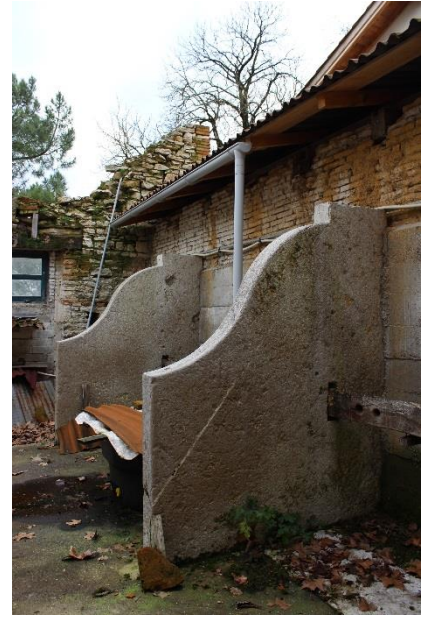
Bat-flancs monolithes dans l'étable au Truc. Chacun mesure 2,40 m de hauteur ; 1,86 m de largeur ; 17 cm d'épaisseur, avec un ancrage d'environ 50 cm dans le sol.
