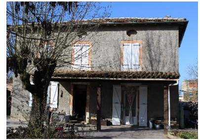
Logis de Benech-haut où se trouvait la cheminée devant laquelle posent les époux Momméja au début du XXe siècle.
