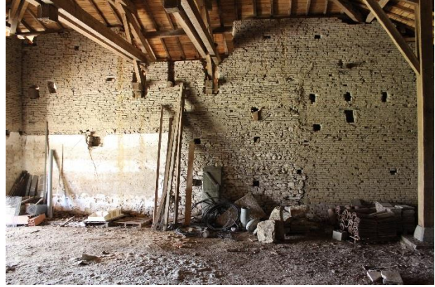
Grange-étable à Gouzes, reconstruite sur une précédente en partie en pierre. Les vestiges englobés sont visibles au centre du mur reconstruit en adobe.
