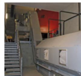
Acheminement du combustible vers la chaudière par convoyeur à bande.
