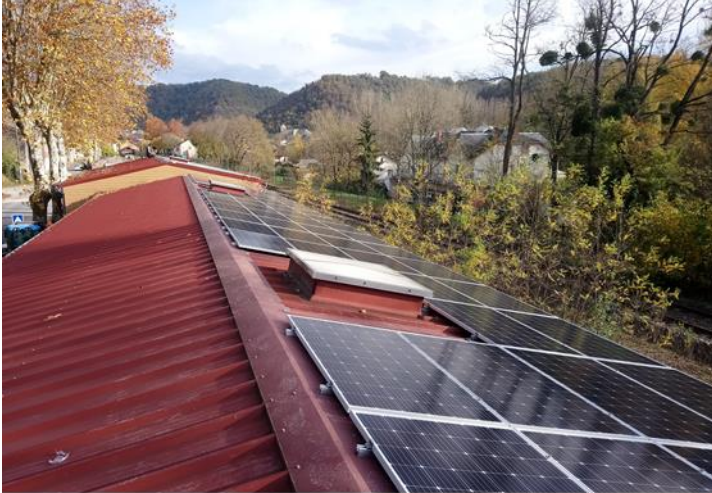
Photo: Installation photovoltaïque - ateliers municipaux Laguépie - 34 kWc
