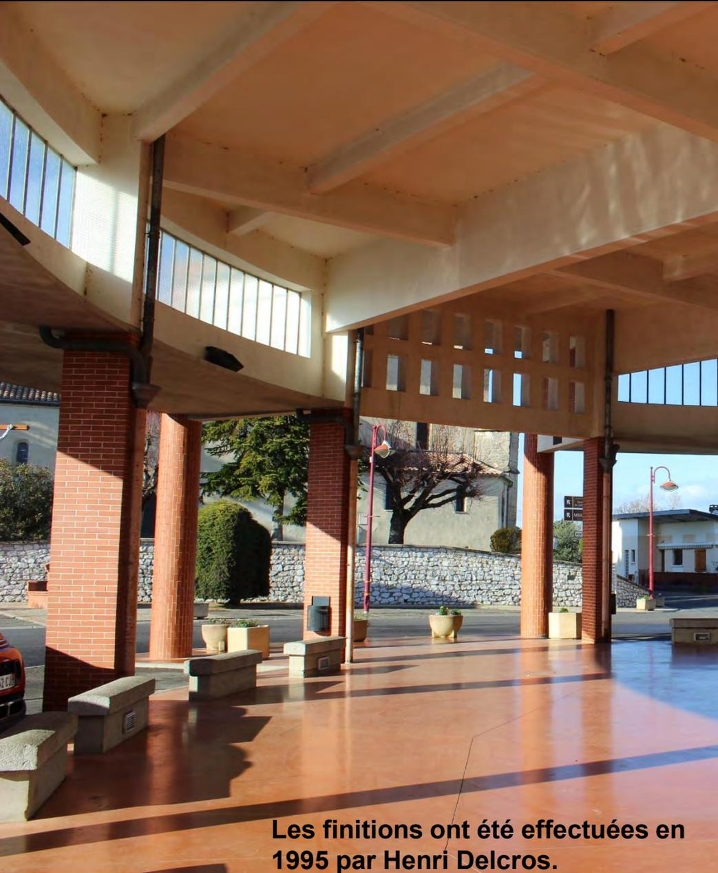
Le ciment armé sera laissé brut de décoffrage, les plaques de coffrage seront rabotées pour les parties apparentes. Tous les piliers seront recouverts d'un revêtement en briques dites mulot pour rester apparentes, les joints tirés au fer. une frise de briques encastrées est prévue sur les bords de l'auvent et du portique ainsi que deux panneaux de briques sur les côtés intérieurs du portique, dont les parties ciment seront bouchardées.
