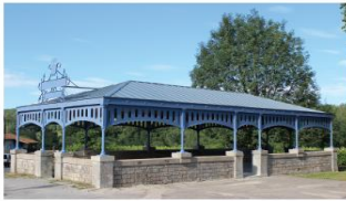
Vue de l'ancien lavoir après les travaux de 2017.
